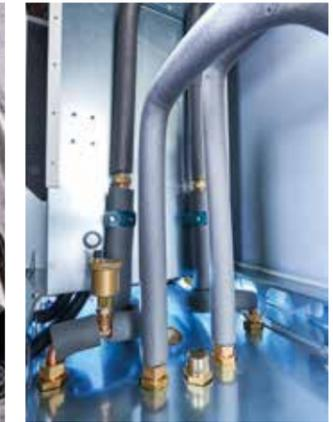
Durch den ausgereiften Gas-/Luftverbund sind die Geräte ab Werk voreingestellt, dies erleichtert die Inbetriebnahme und die Messwertkontrolle. Das Ausdehnungsgefäß (10 l) ist bereits integriert.
